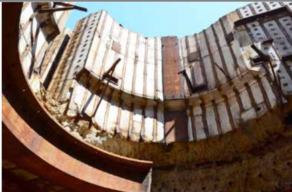
Рис.7 Тërмооболочка из армированного бетона
